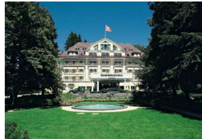
Grand Hotel Bellevue, Gstaad. Schwimmbad-Entfeuchtungsgerät mit hocheffizienter WRG und Wärmepumpe.
