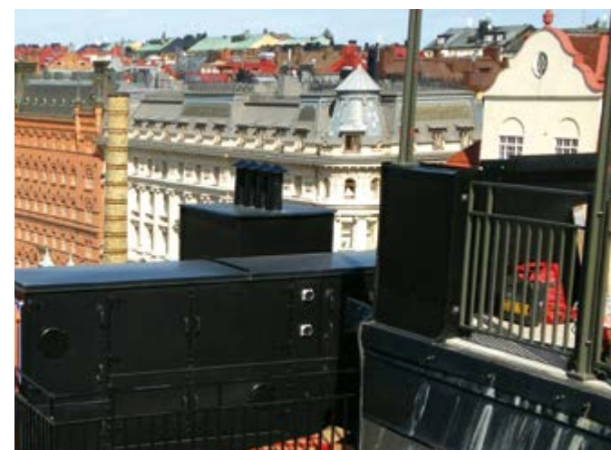
Pool Line Dachgerät mit Schaltschrank, Strömvägen, Stockholm
