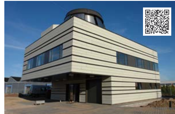
Ein HKG-P-034 belüftet das neue Laborgebäude des Fraunhofer-Instituts in Ilmenau.
