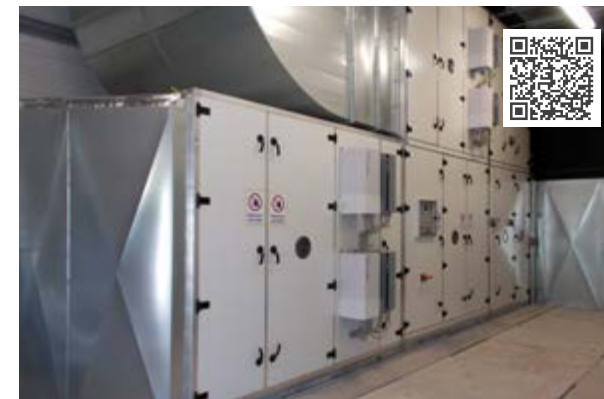
Entwärmung der Konverterstation DoWin 3, 4 Free Line Geräte mit Luftvolumenströmen von 50 000 m 3 /h, Kälteleistungen von 320 kW und integrierten Elektrolufterhitzern.
