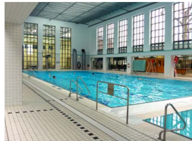
Stadtbad Schöneberg, Berlin. Wetterfestes Schwimmbad-Entfeuchtungsgerät mit Wärmepumpe.
