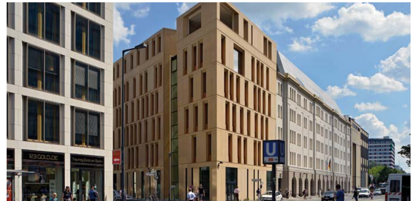
Der Dienstsitz des Bundesministerium für Umwelt, Naturschutz und Reaktorsicherheit in Berlin ist ein Passivhaus-Projekt, belüftet durch HANSA-Accu Geräte mit hocheffizienter Wärme- und Feuchterückgewinnung.
