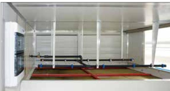
Bei Kühlbedarf wird ein Doppelplatten-Wärmetauscher abluftseitig mit hochfein zerstäubtem Wasser besprüht, wobei die Abluft durch adiabate Befeuchtung heruntergekühlt und dem Tauscher die zur
