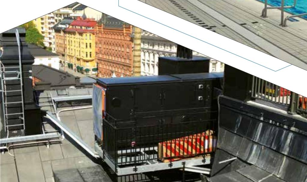
Pool Line Dachgerät mit Schaltschrank,
