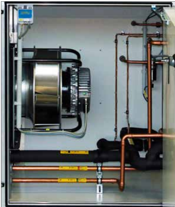
EC-Ventilatormodul (ebm-papst) in Standard-Ausführung mit Spinne (schwingungsentkoppelte Befestigung am Druckschott).
