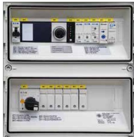
Natürlich entspricht der Schaltschrank der DIN 10505: Es existiert ein ausfallsicherer Betriebsstundenzähler und die Grenzdrücke werden optisch angezeigt.
