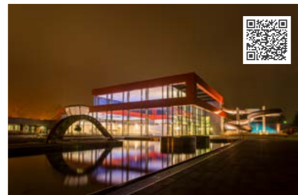
Das „DeBalje“ in Aurich: Vollständige Ausrüstung mit HANSA-Klimatechnik (Entfeuchtung mit 50 000 m 3 /h, diverse Lüftungsgeräte für Nebenräume einschließlich Küche und Sauna).
