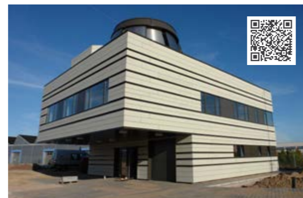
Ein HKG-P-034 belüftet das neue Laborgebäude des Fraunhofer-Instituts in Ilmenau.
