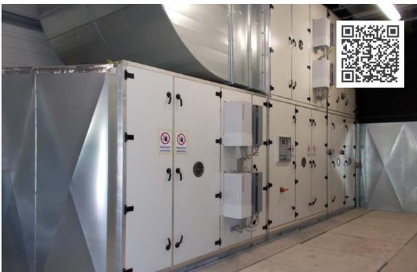
Entwärmung der Konverterstation DolWin 3, 4 Free Line Geräte mit Luftvolumenströmen von 50 000 m<sup>3</sup>/h, Kälteleistungen von 320 kW und integrierten Elektrolufterhitzern.
