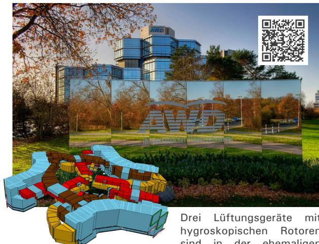
Drei Lüftungsgeräte mit hygroskopischen Rotoren sind in der ehemaligen Konzernzentrale der AWD exakt in die Trakte des Gebäudes eingefasst worden (kleines Bild unten links, blaue Elemente). Insgesamt wurde eine Luftleistung von 290 000 m<sup>3</sup>/h installiert.
