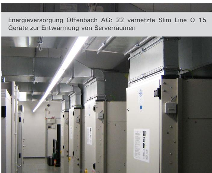
Energieversorgung Offenbach AG: 22 vernetzte Slim Line Q 15 Geräte zur Entwärmung von Serverräumen
