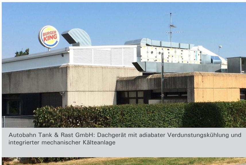
Autobahn Tank & Rast GmbH: Dachgerät mit adiabater Verdunstungskühlung und integrierter mechanischer Kälteanlage
